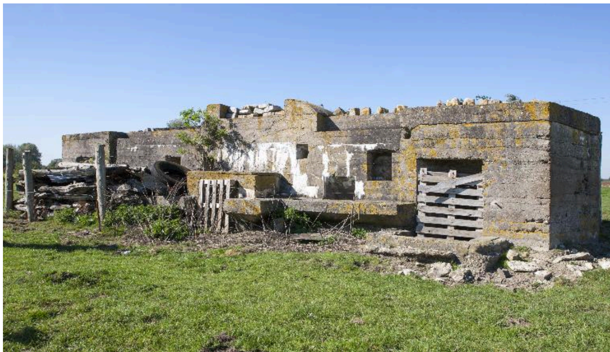
Elévation sud, vers le nord-ouest
