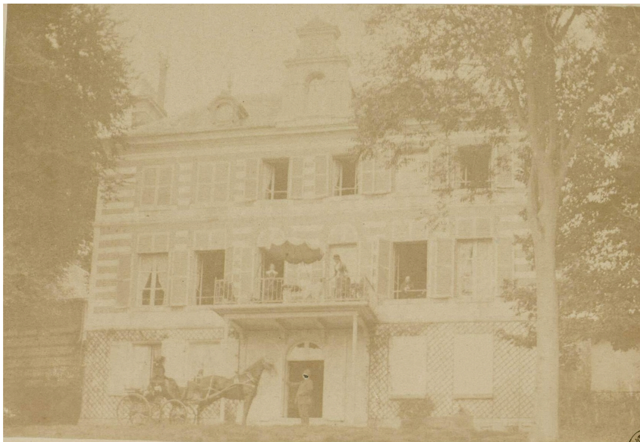
Habitation de M. Henri Devismes de Flacourt à Laviers, photographie noir et blanc, par Maurice de Féraudy, 1884 (Archives et Bibliothèque patrimoniale d'Abbeville ; Ab. N63).
