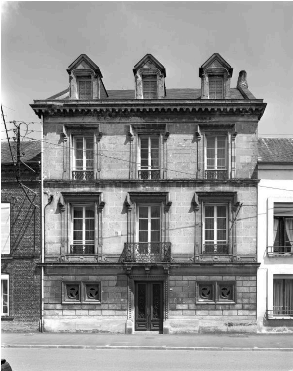
Vue de la façade sur rue.
