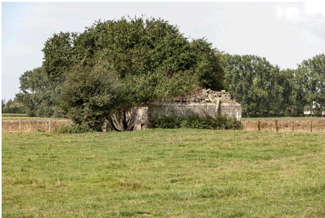
Vue vers le nord-ouest
