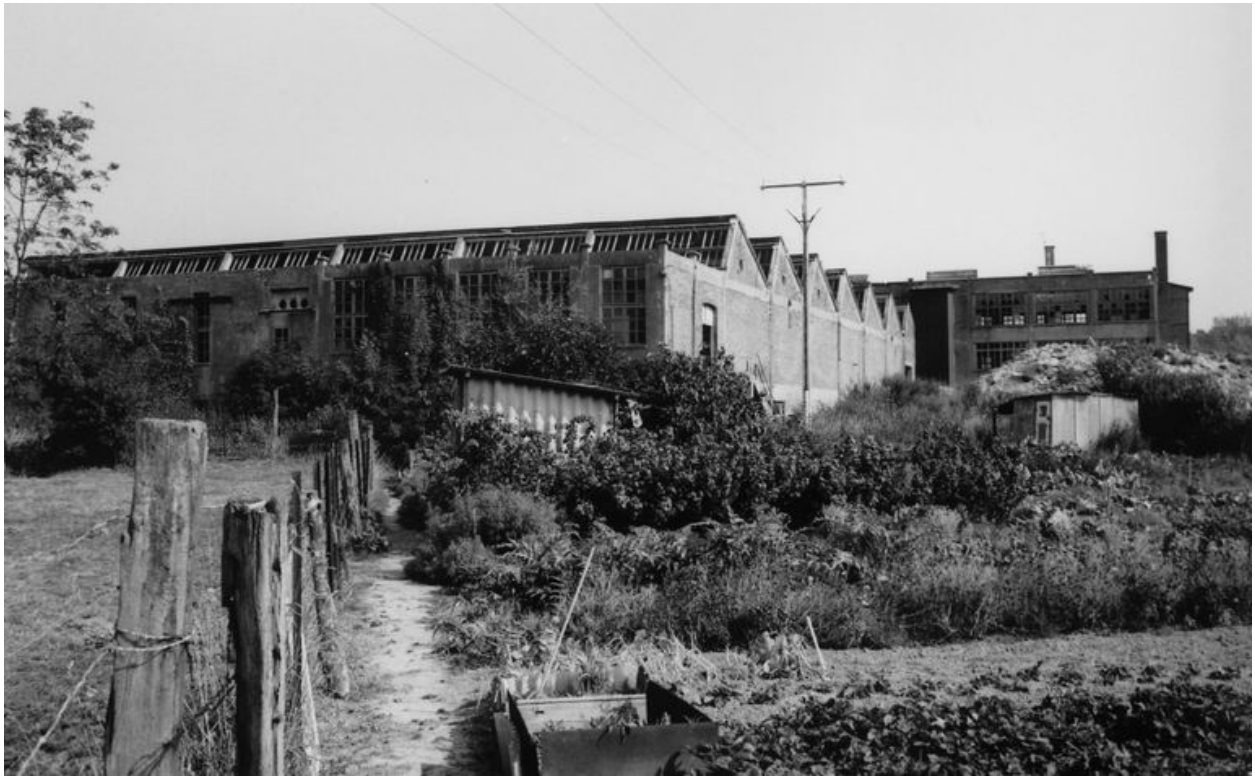
Atelier de fabrication (tissage), flanc sud-ouest.
