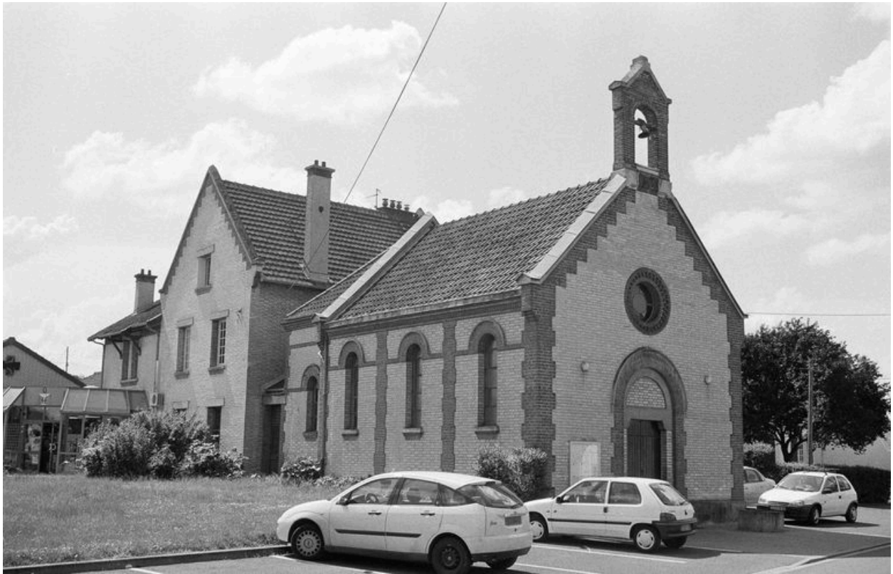
Chapelle : vue générale nord-est.
