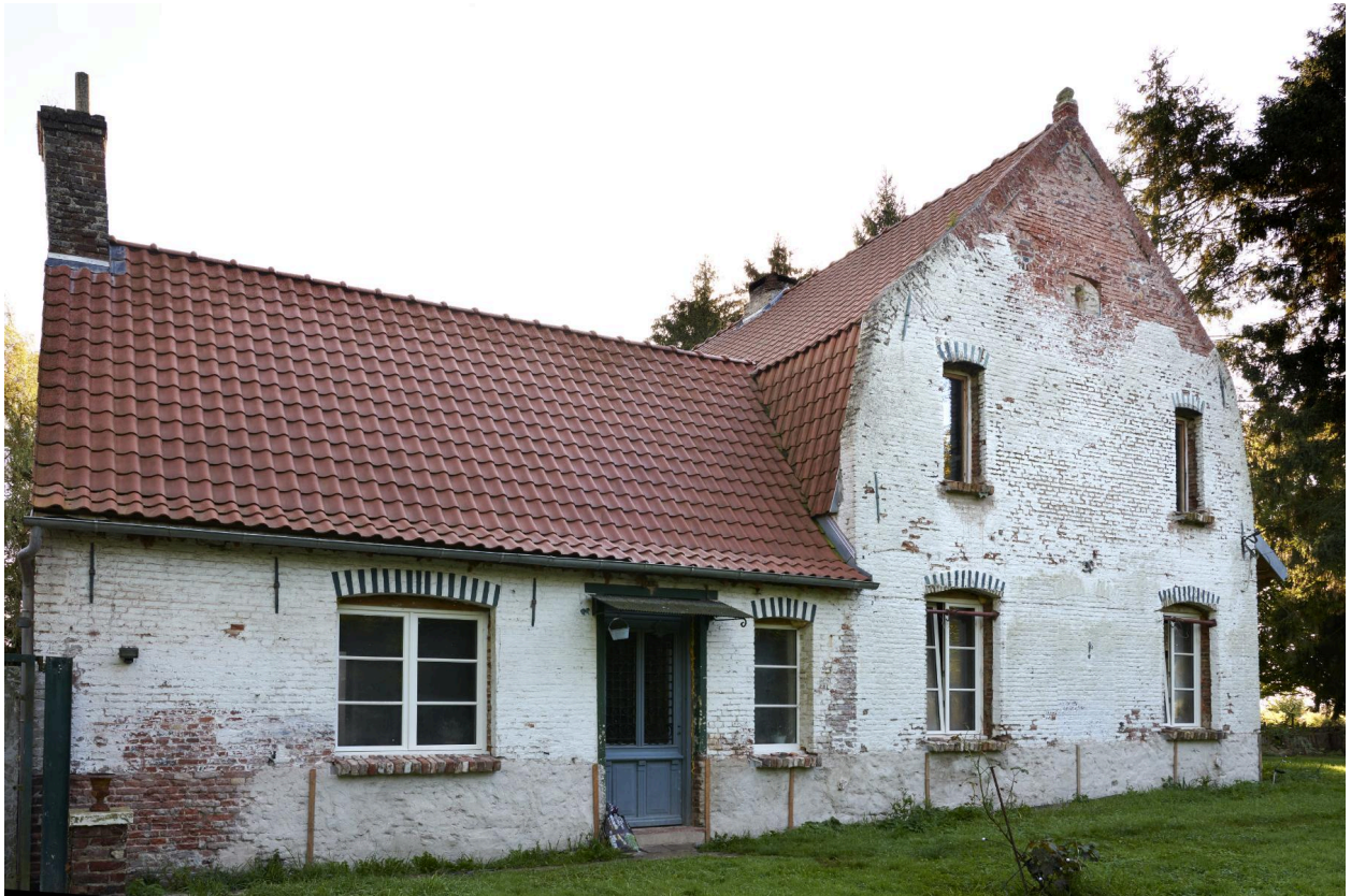
Vue d'ensemble de l'aile orientale.
