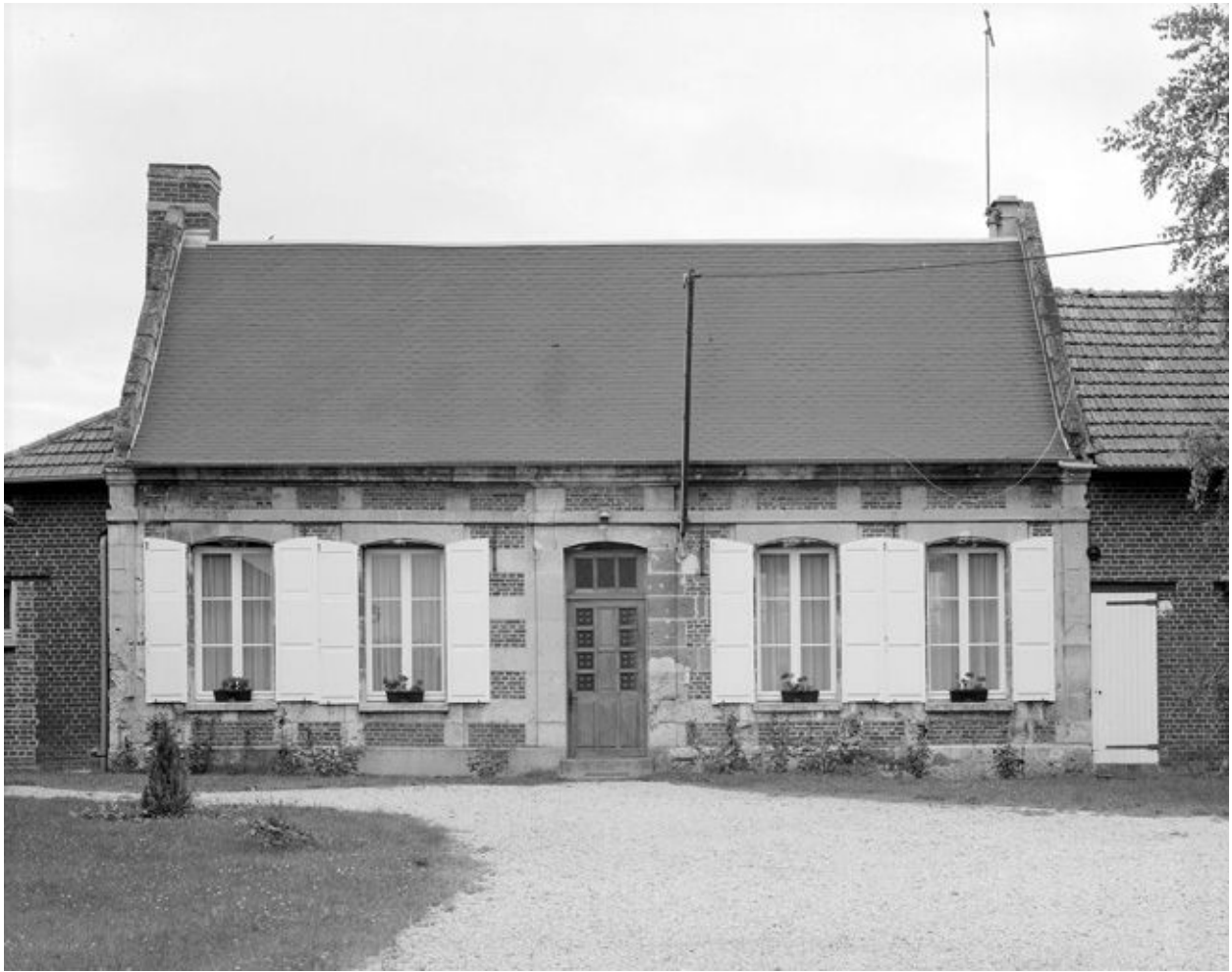
Logis. Élévation antérieure.
