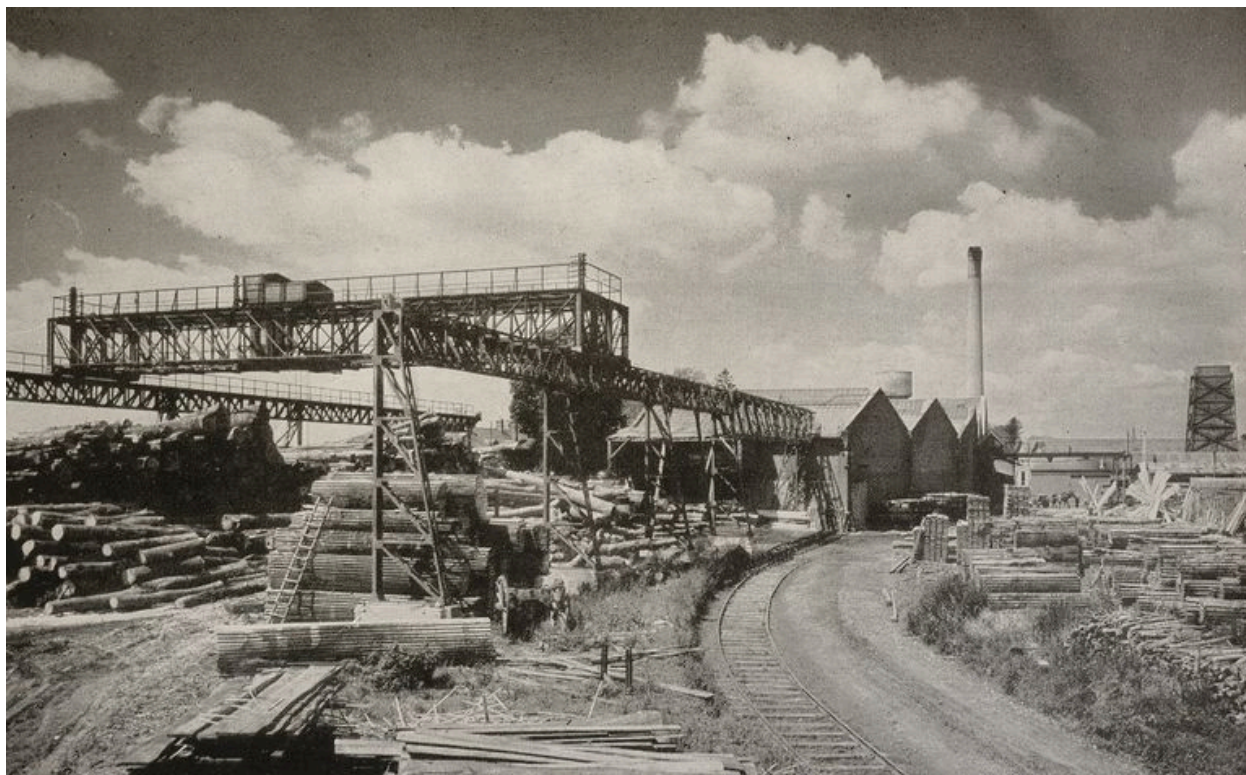
Vue générale de la scierie Petit en 1954.
