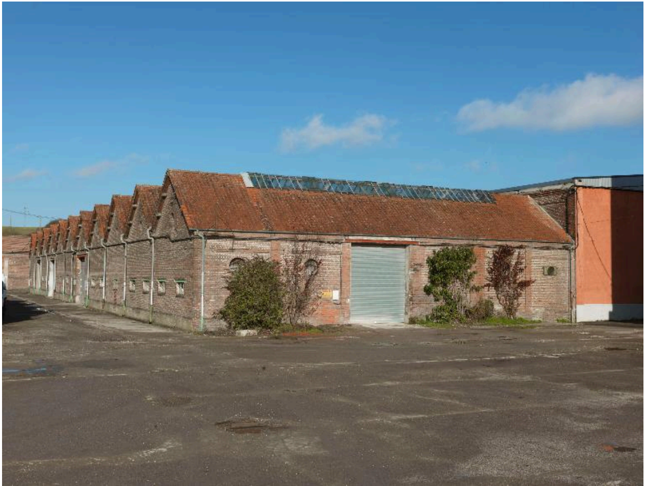
Bâtiment de l'ancienne filature.
