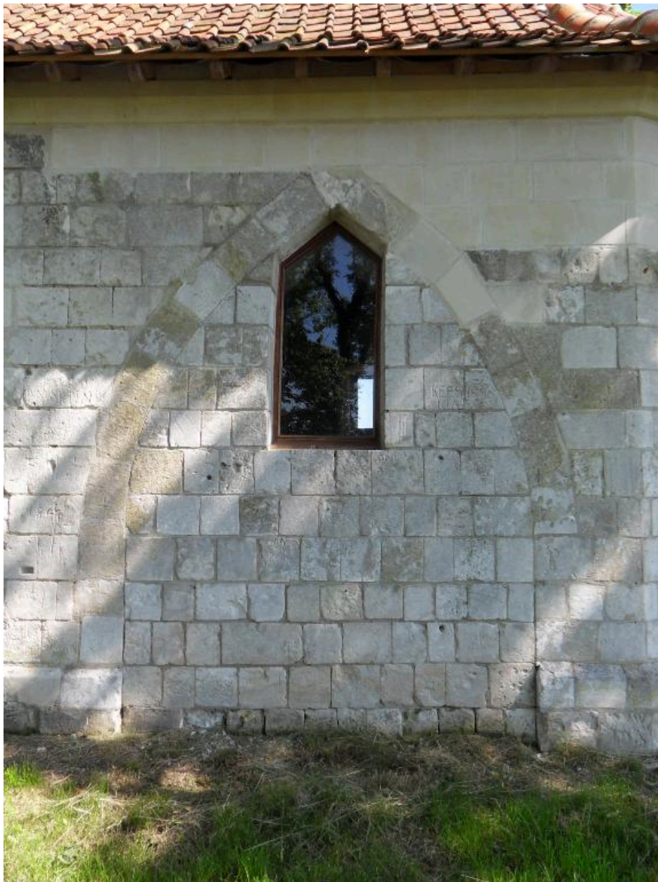
Troisième arcature mur sud.
