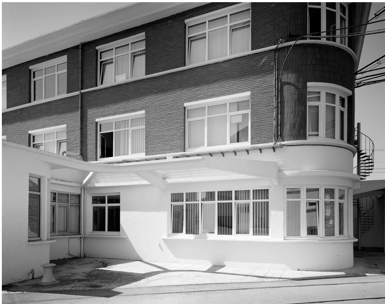
L'entrée des anciens bureaux de l'usine Sambre et Meuse, actuellement propriété de la Ville de Jeumont.
