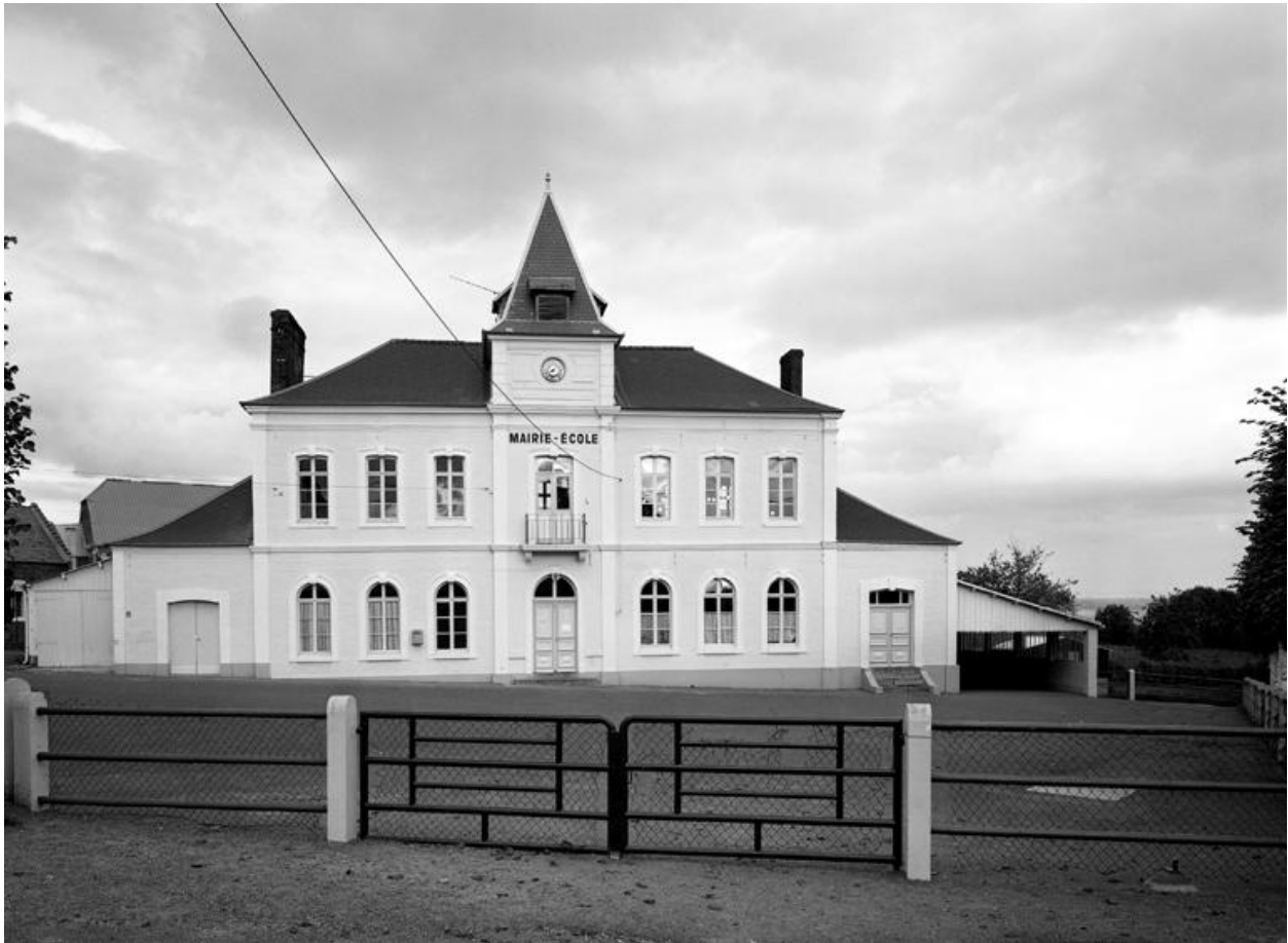
Vue d'ensemble de la façade.
