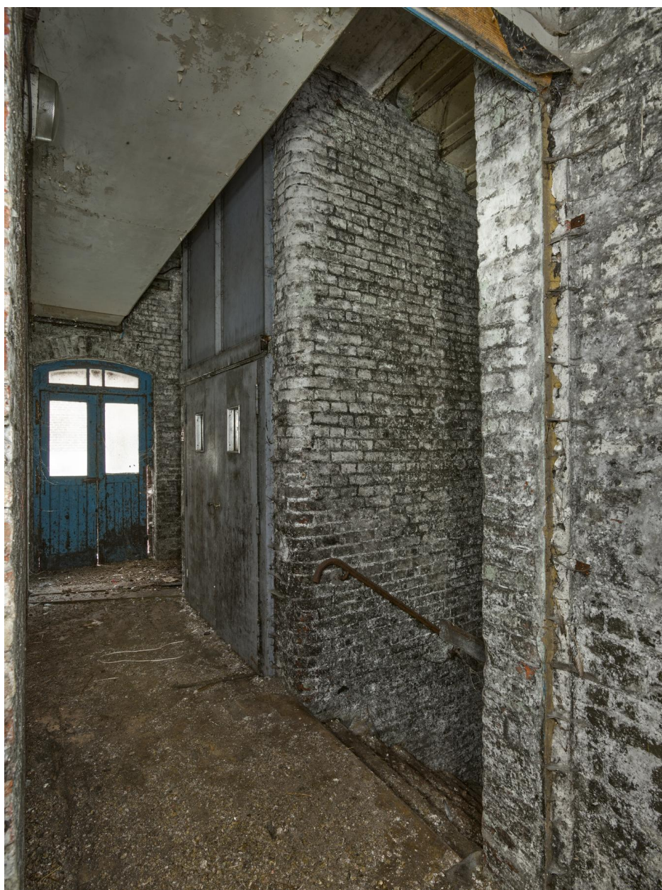
Escalier et monte-charge au deuxième étage de l'atelier de fabrication (bâtiment K).
