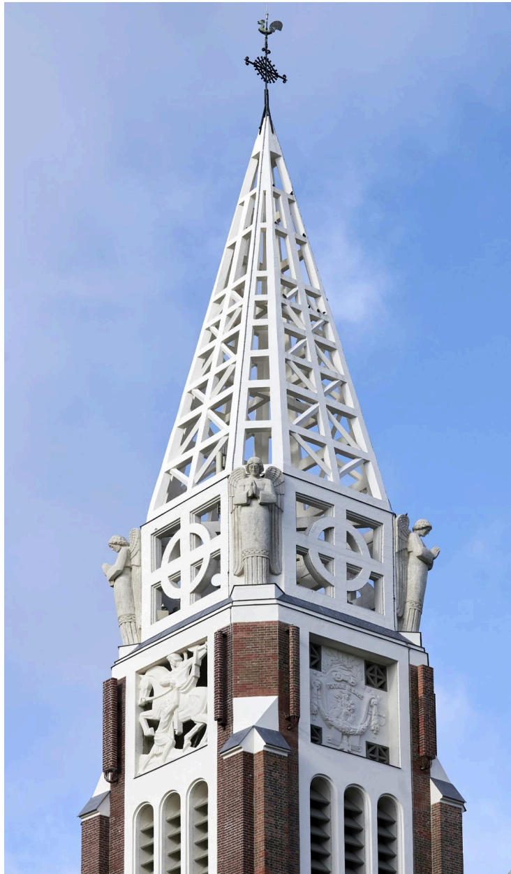
Vue générale de la partie haute du clocher-porche.
