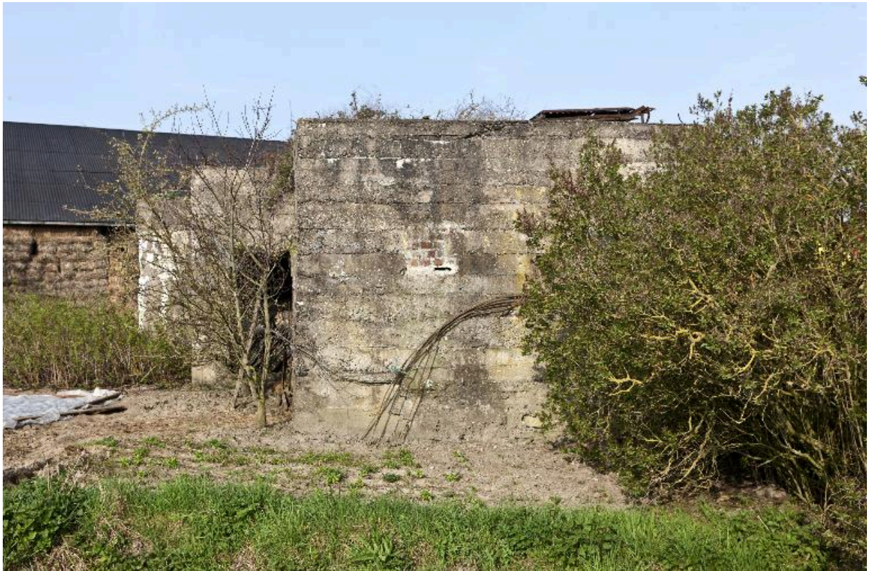
Vue latérale, vers l'ouest
