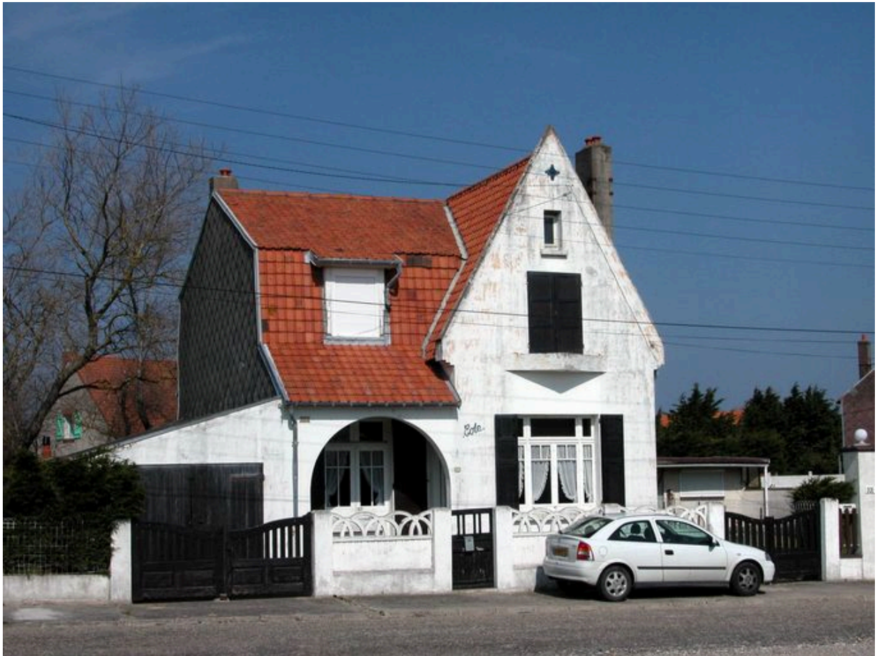
Clôture influencée par le style Art déco (Eole, 89 rue des Oyats).
