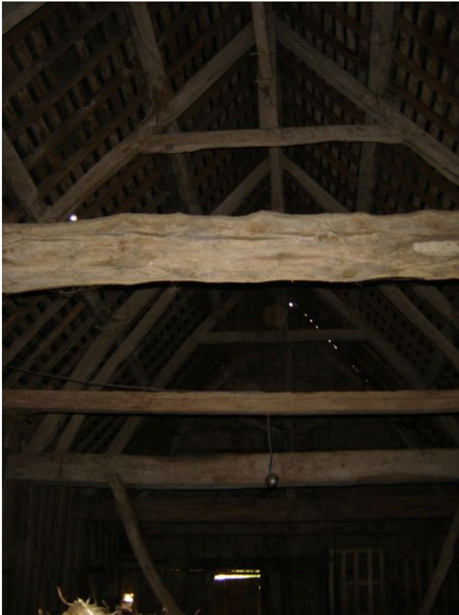
Vue des fermes composant la charpente de la grange.
