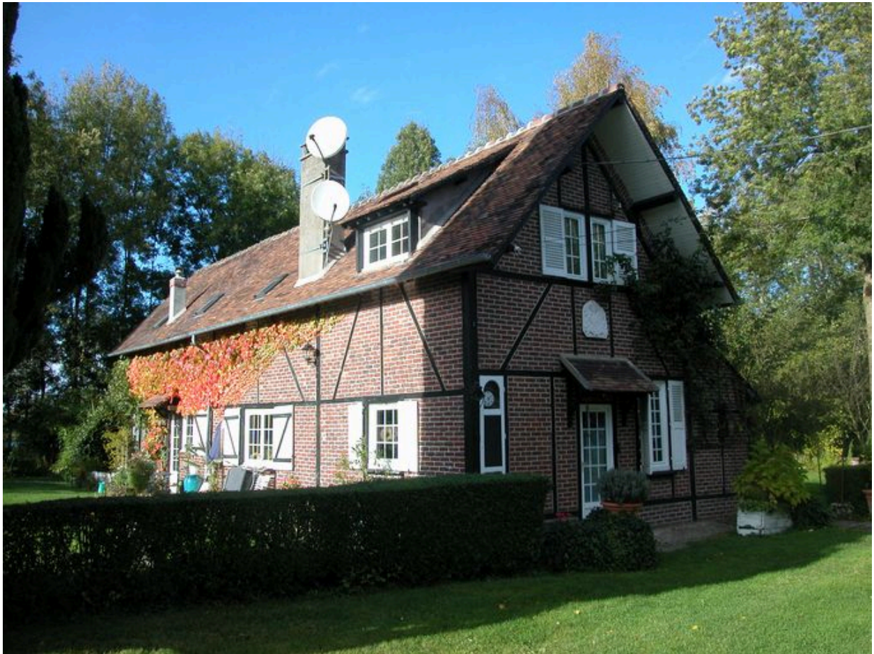
Logement d'ouvrier à proximité de la scierie.
