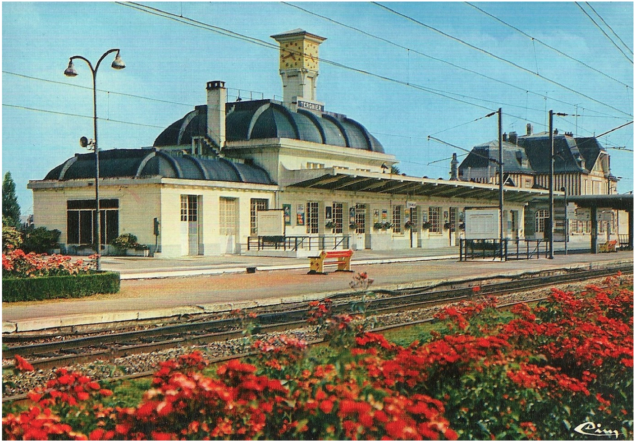
La gare de Tergnier. Vue depuis les quais. Carte postale, 3e quart 20e siècle (coll. part.).
