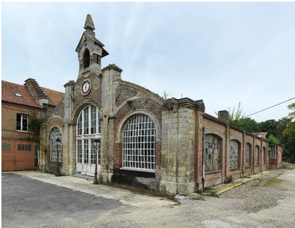
Vue de trois-quarts des ateliers de fabrication.
