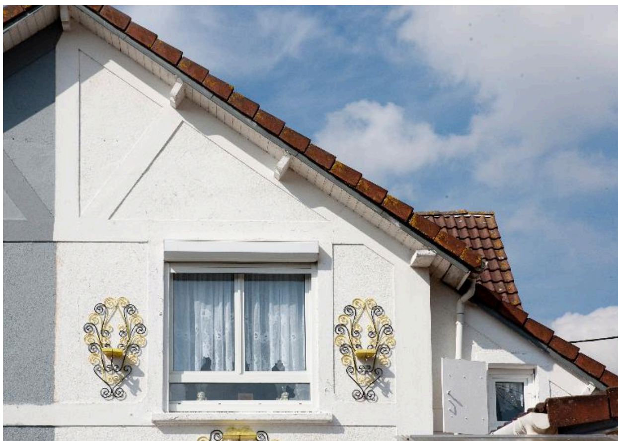
Façade de la maison sur cour, détail.
