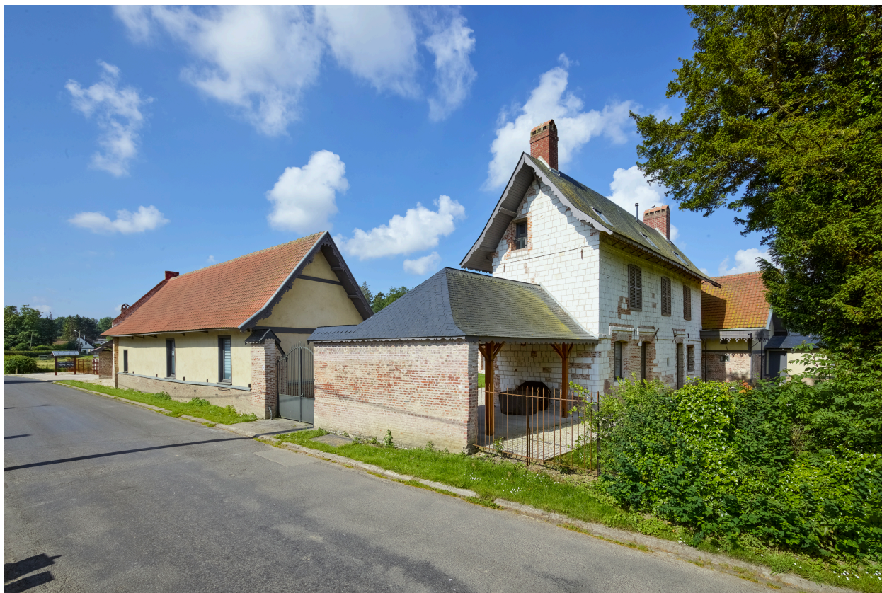
Vue nord de la ferme, depuis la rue.
