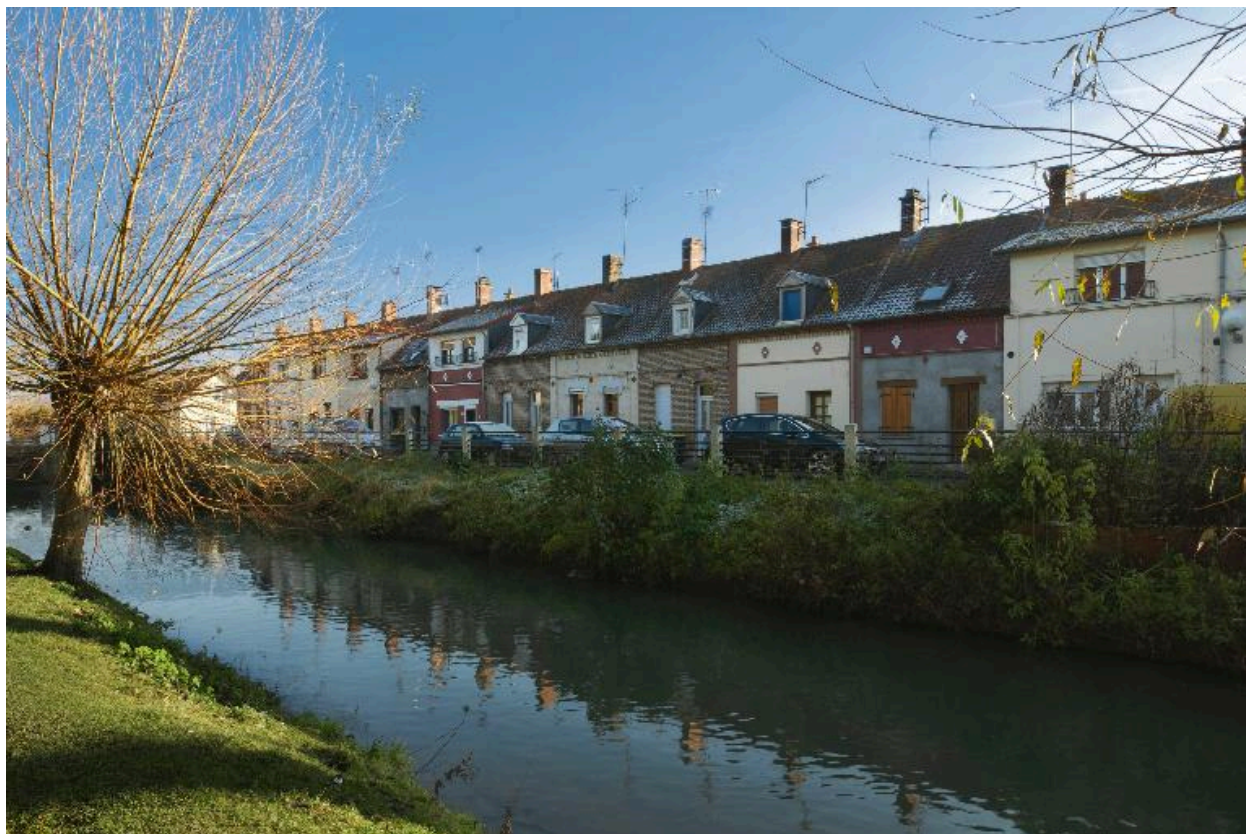
Vue d'ensemble des façades des logements de la rue Marius-Sire.
