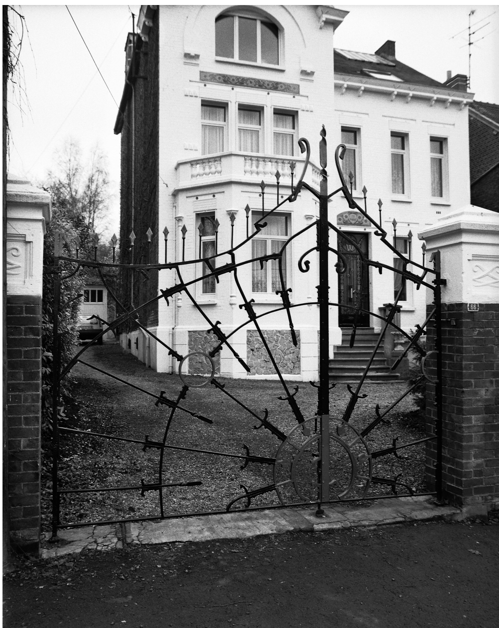
Vue générale de la grille en ferronnerie (représentant un soleil).
