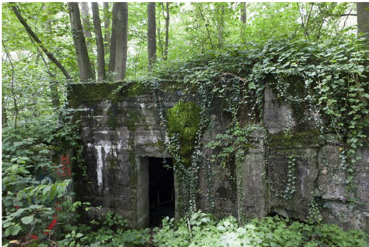
Casemate n°3, élévation antérieure, partie sud.
