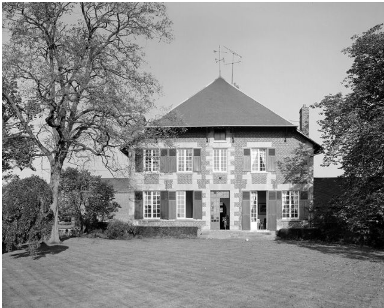
Logis. Elévation postérieure sur jardin.
