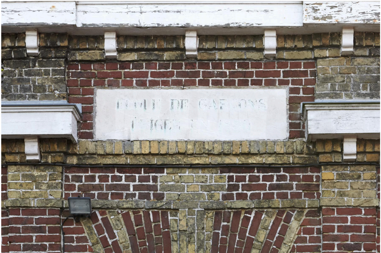
Bâtiment sud-est, détail, plaque gravée "ÉCOLE DE GARÇONS / ÉRIGÉE EN 1890".
