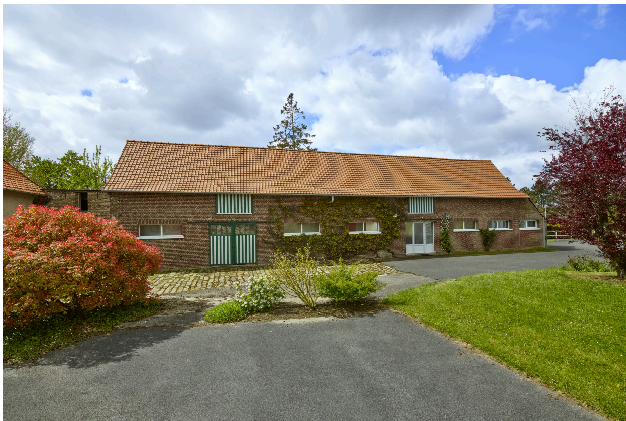
Façade nord de l'ancien bâtiment agricole, depuis la cour.
