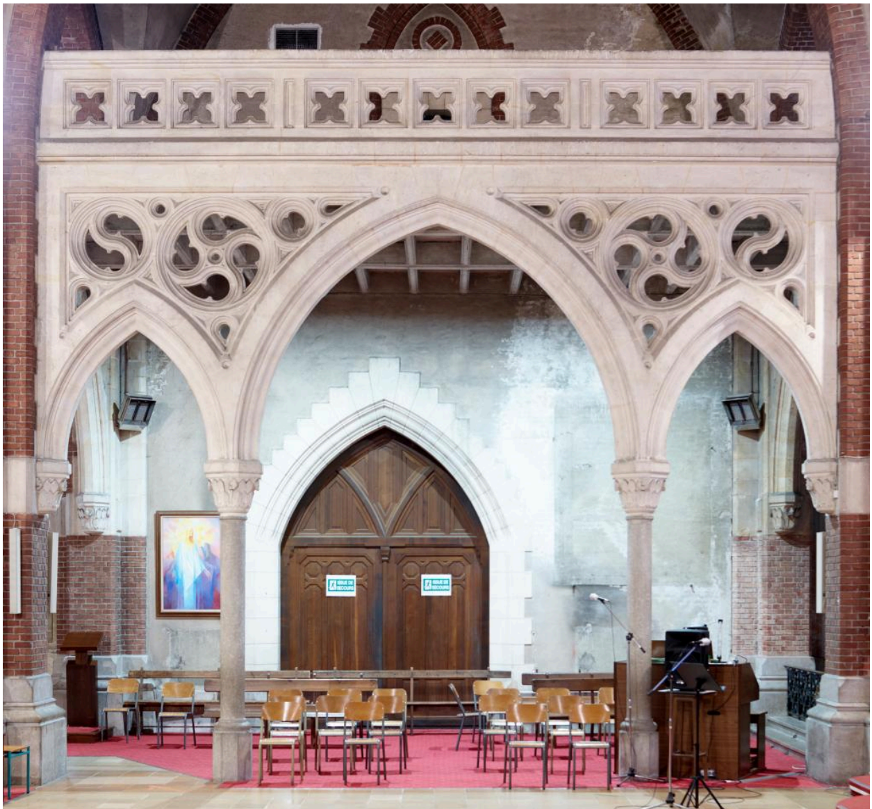
Tribune néogothique. Vue depuis la nef de la façade Est.
