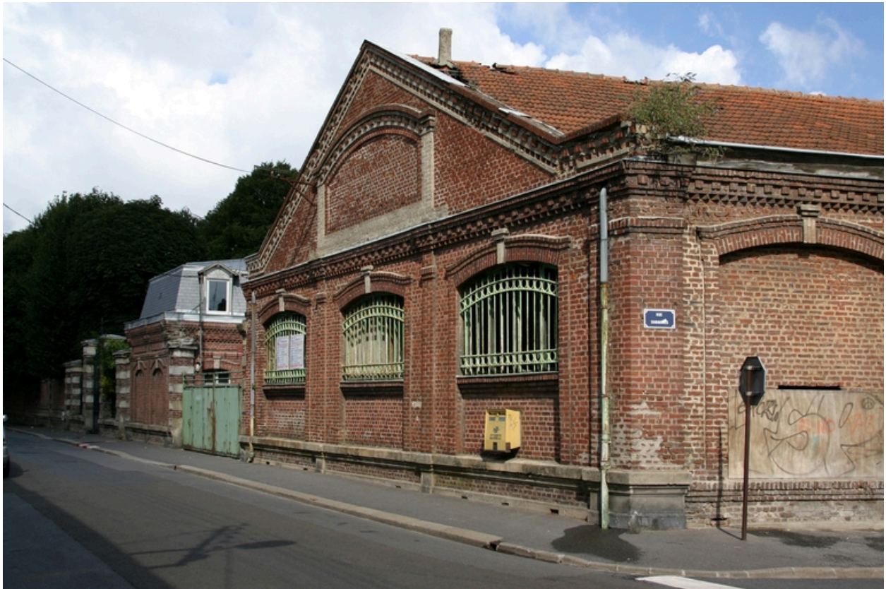
Magasins et entrée de l'usine, vus depuis l'angle des rues Camille-Desmoulins et Sommières.
