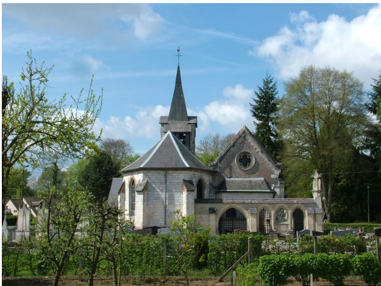
Vue générale de l'église et du cimetière.
