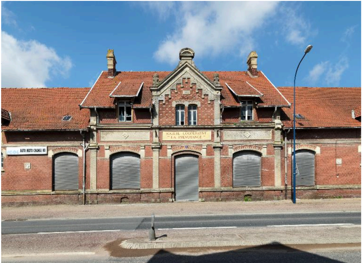
Façade sur rue, vue de face.
