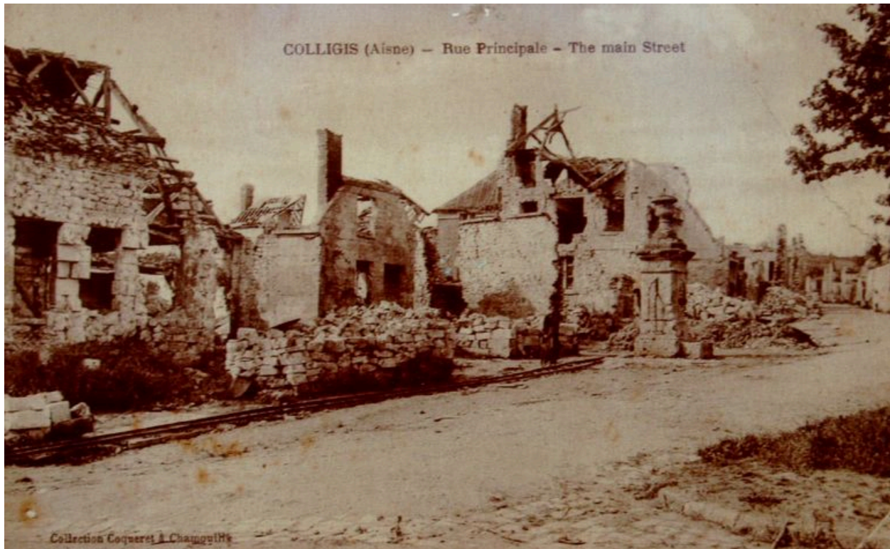
Vue de la rue principale de Colligis détruite (A.C. Colligis).
