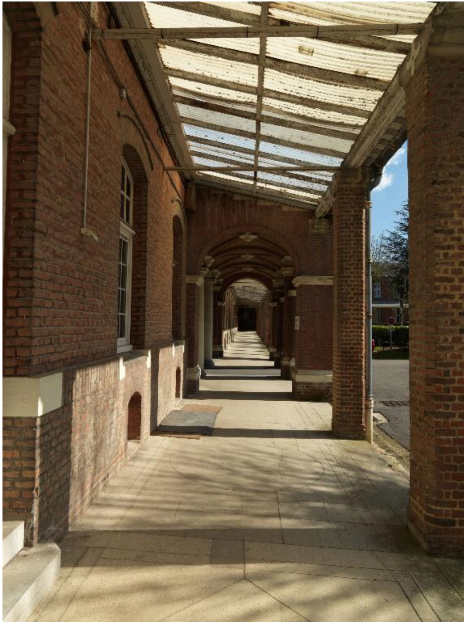
La galerie du bâtiment de l'administration.
