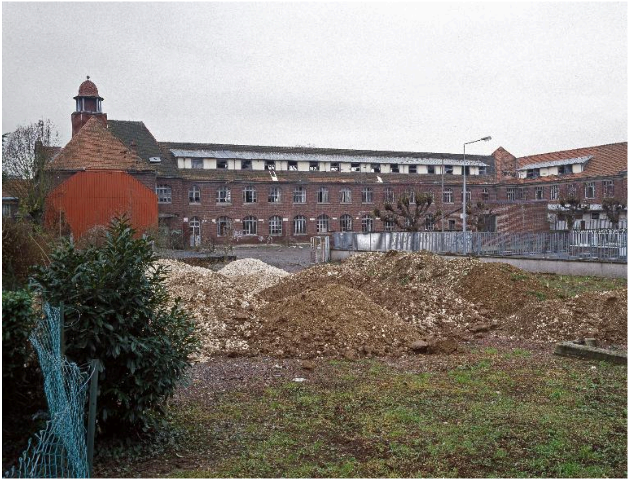
Façade, vue prise depuis la rue Edmond-Carré, vers la rue Victor-Hugo.
