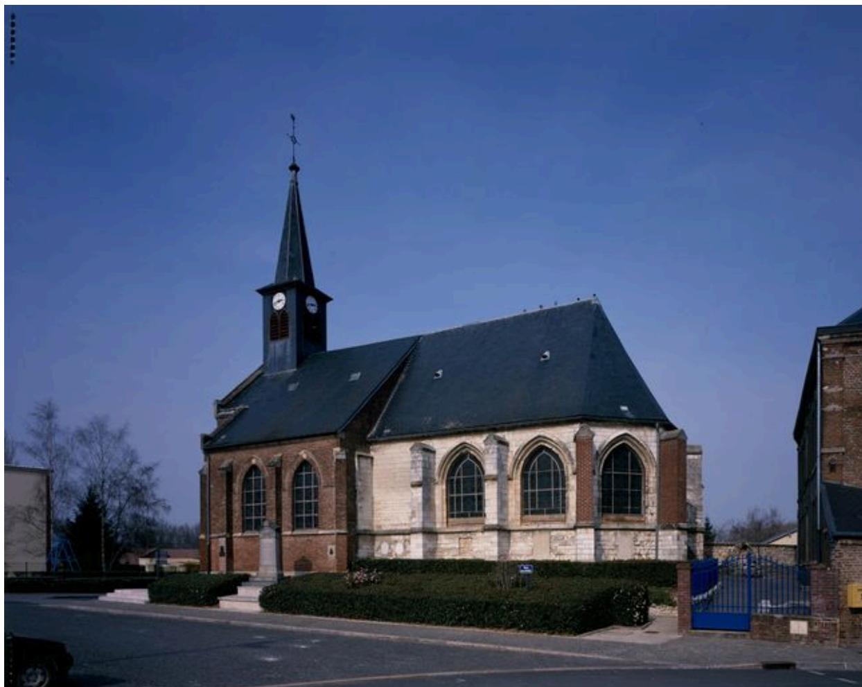
Vue générale, depuis le sud-est.
