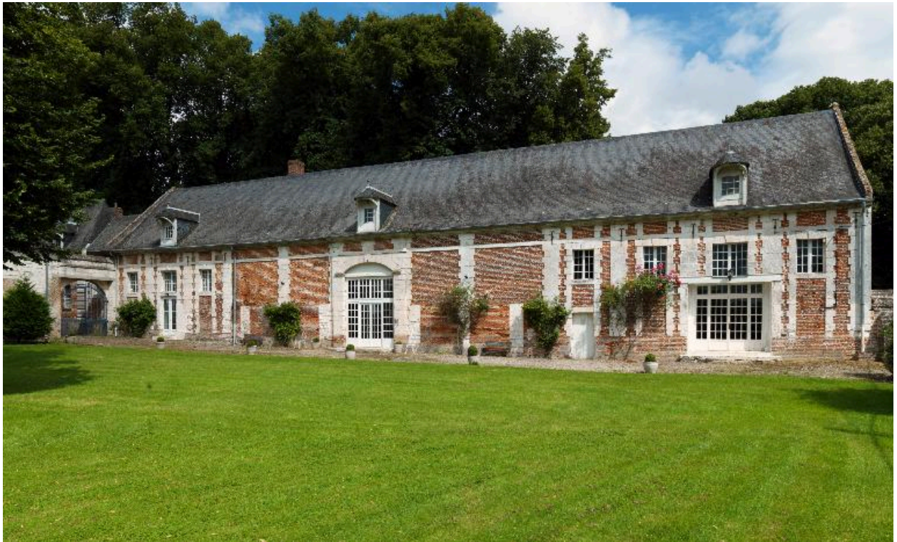
Vue du bâtiment d'exploitation depuis la basse-cour.
