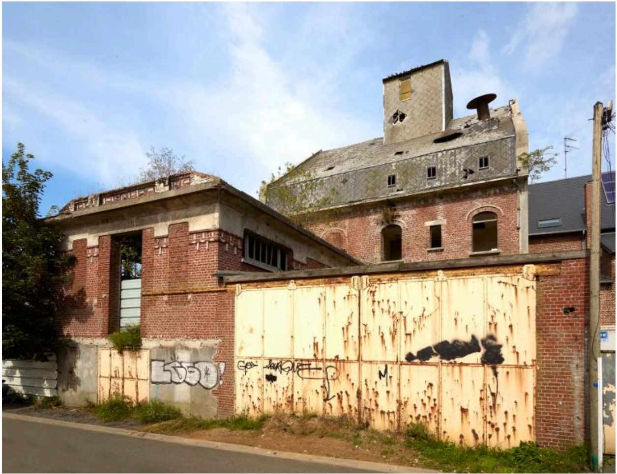
Vue arrière, depuis la rue Charmante, l'ancienne salle à manger au premier plan.
