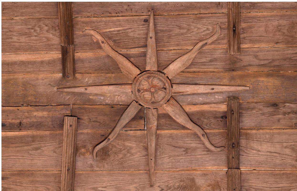
Décor sur le lambris de la charpente de la nef : soleil.
