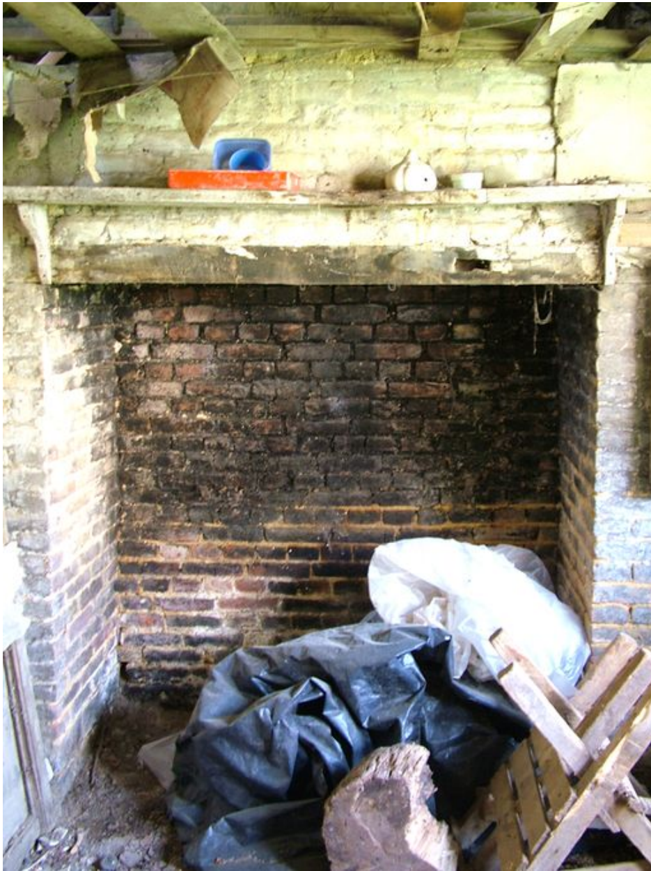
Cheminée du séchoir à chanvre.
