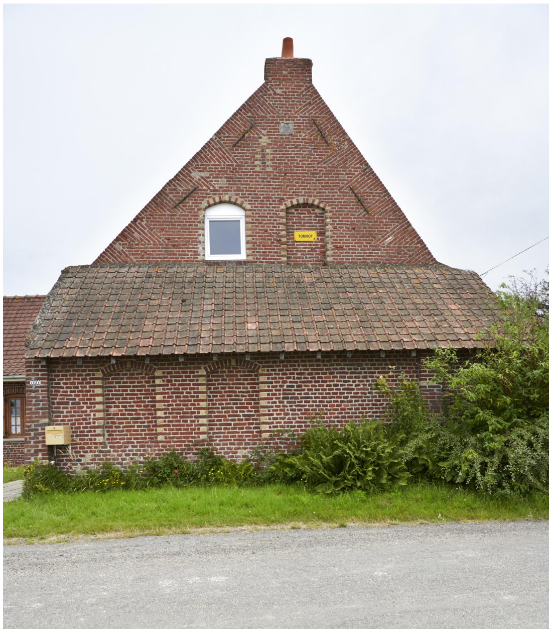
Pignon ouest et appentis adossé, sur rue.
