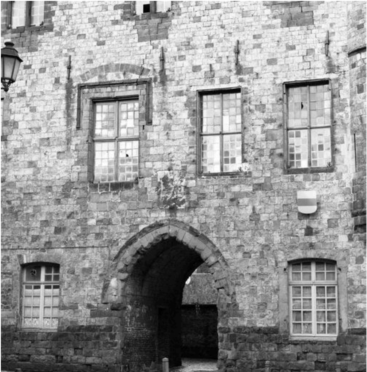
Corps de logis médiéval, façade, vue partielle : rez-de-chaussée et 1er étage, percements.
