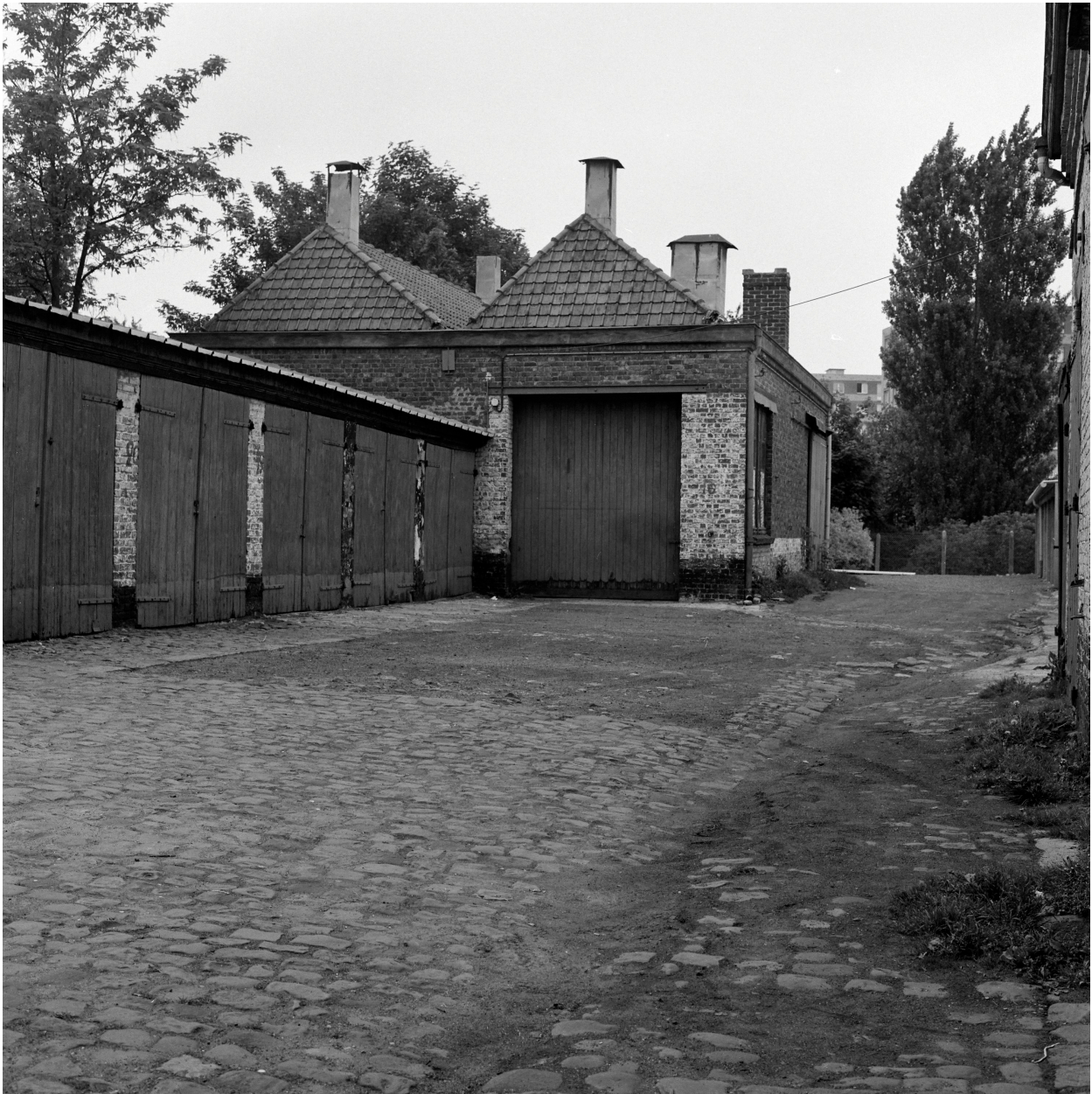
Ateliers de fabrication (?). Vue prise vers l'est.
