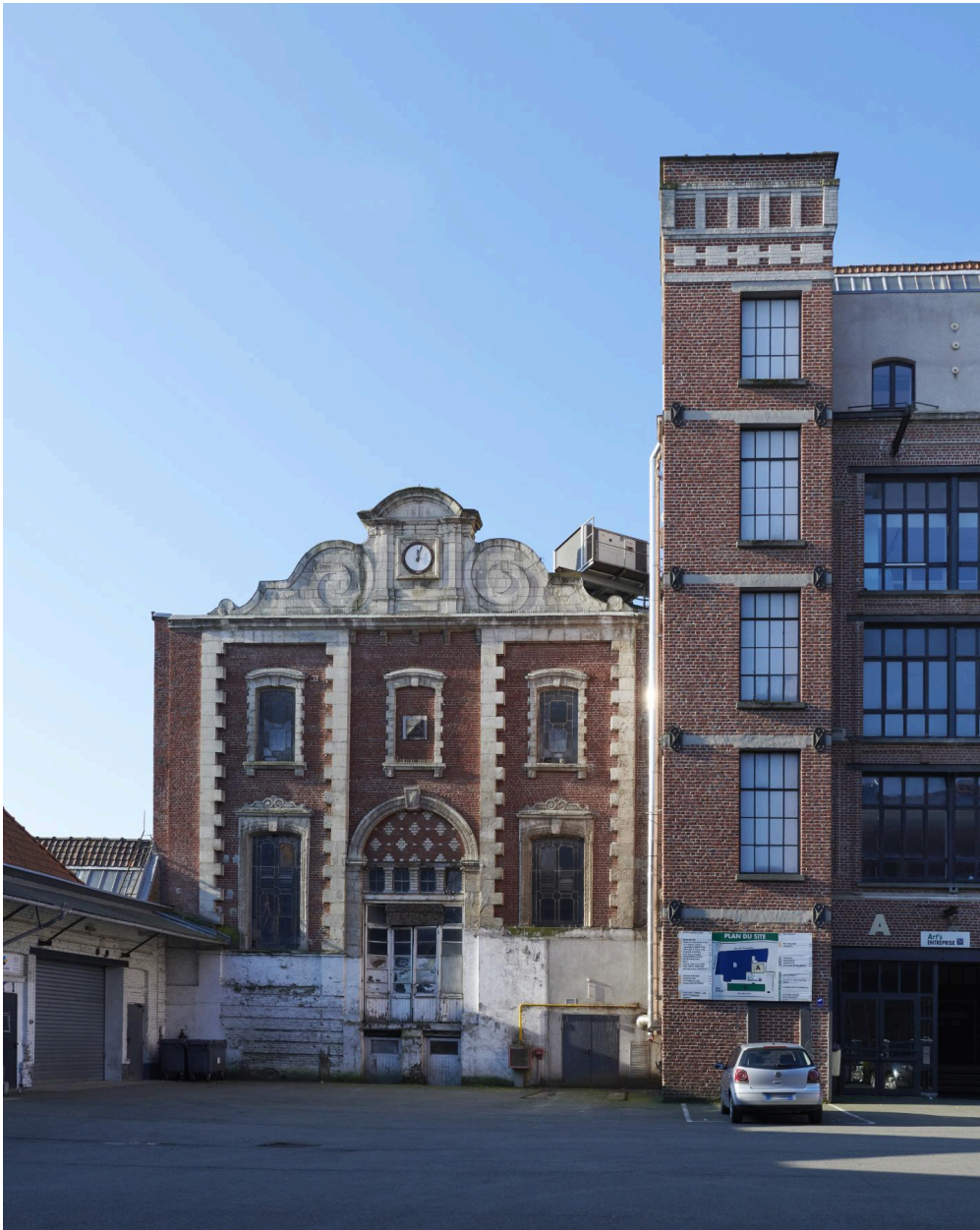
Façade nord et tour donnant sur la cour intérieure.
