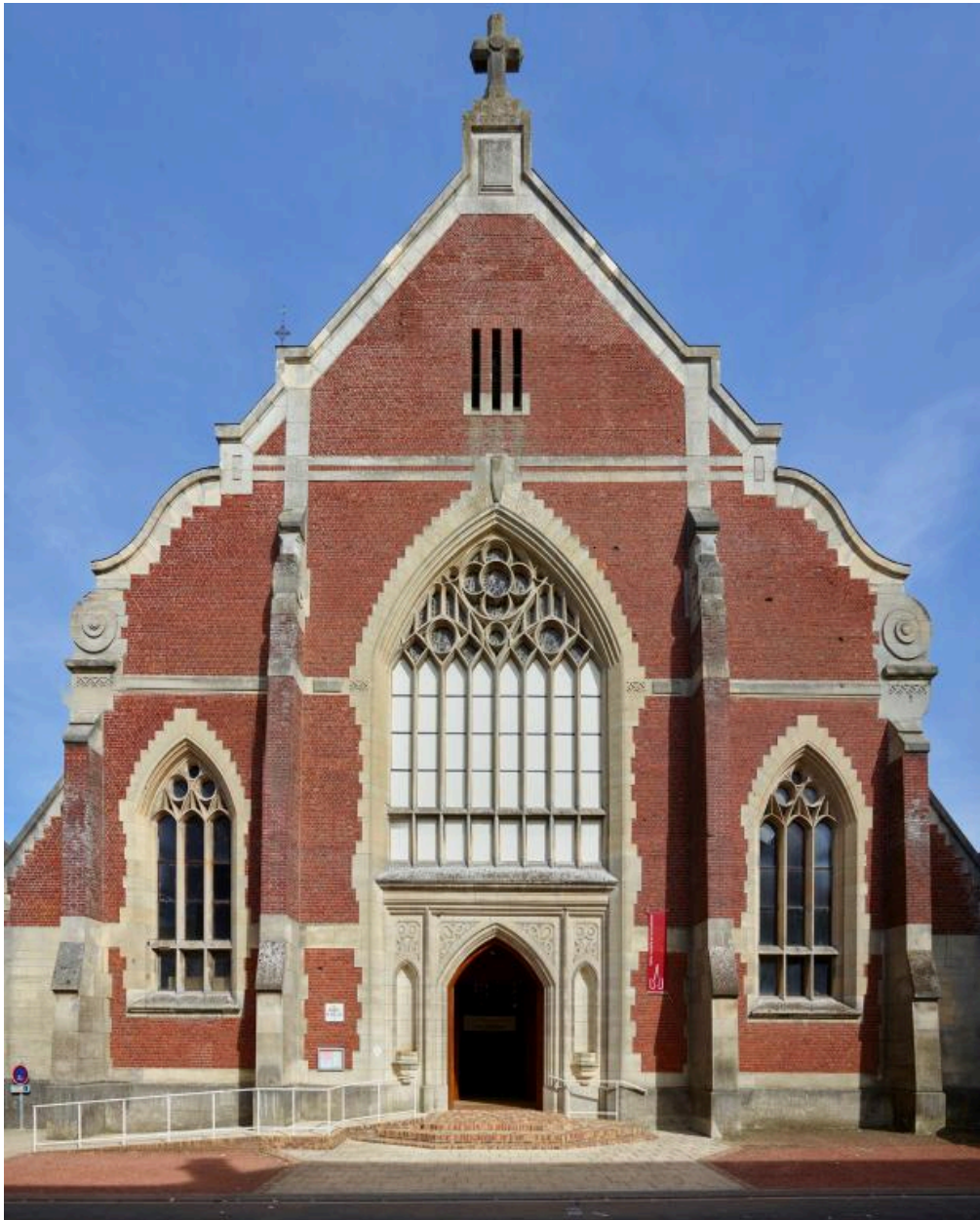
Vue générale de la façade de l'église.
