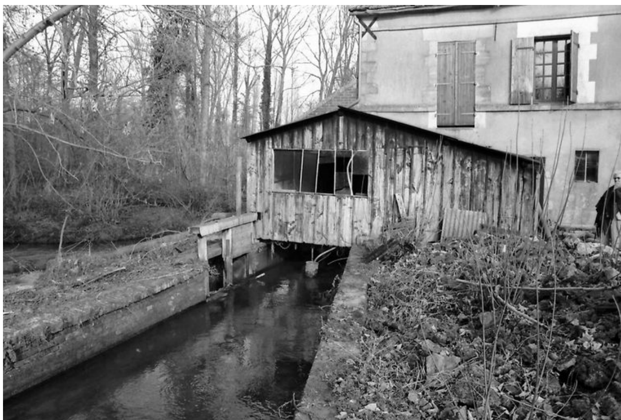
Vue de la rivière canalisée et du lavoir construit à l'avant du moulin.
