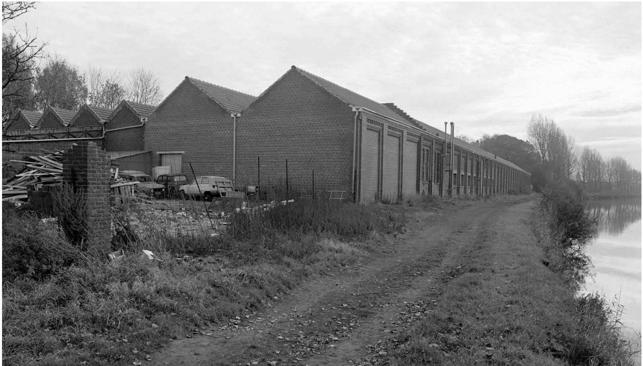
Atelier de fabrication, élévation postérieure sur la Lys, vue prise vers le sud.
