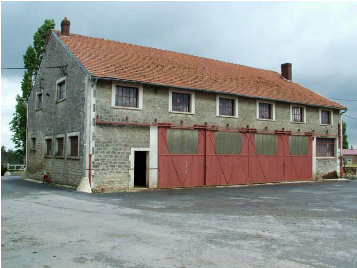
Vue d'un bâtiment agricole.
