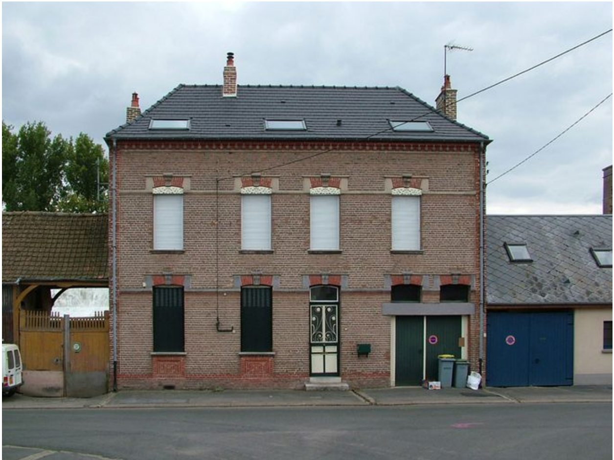
Pernois, maison, 166 rue de la Ville, 2e quart du 20e siècle.
